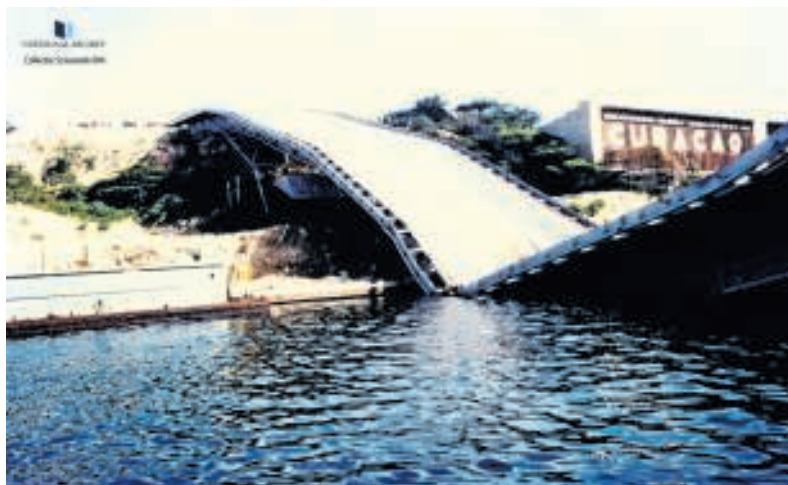
De ingestorte Julianabrug in 1967. FOTO NATIONAAL ARCHIEF, COLLECTIE SCRIVANE
